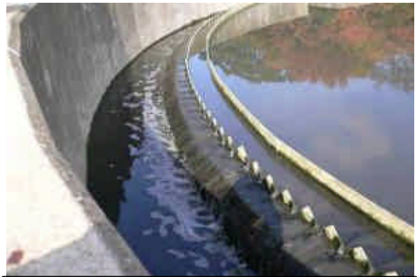
コンコード町下水道処理施設
