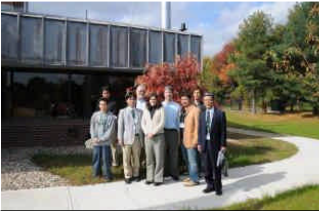
コンコード町下水道処理施設
