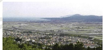
城岱スカイラインから望む七飯町の街並みと北海道新幹線の高架橋
