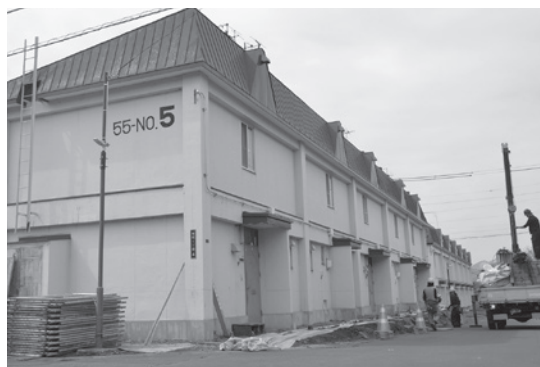
長寿命化に向けた改修工事が行われる桜B団地
