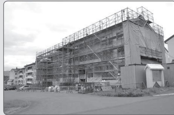
長寿命化改修工事を施工中の町営住宅
