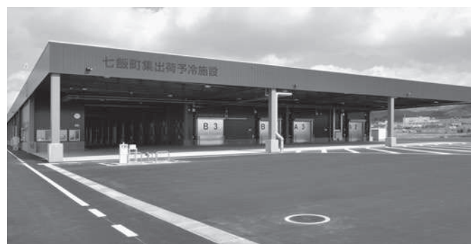
集出荷予冷施設
