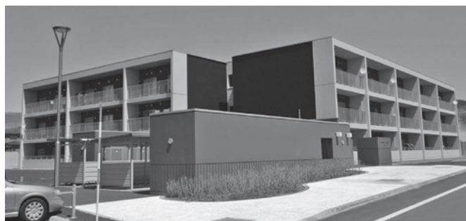
大中山団地（令和2年建築）
