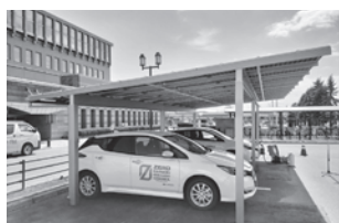
渡島合同庁舎駐車場 ソーラーカーポート
