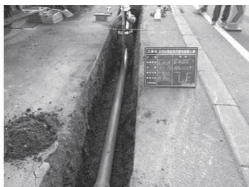
老朽管布設替え工事の様子
