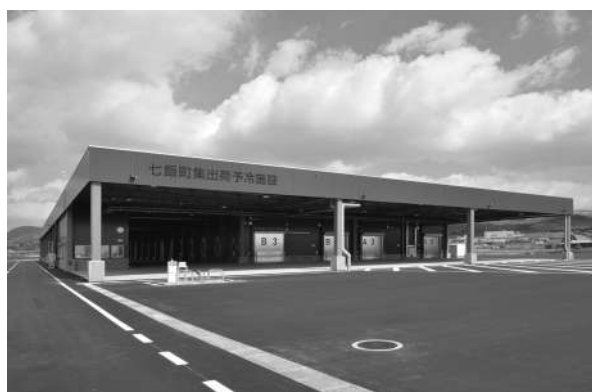
集出荷予冷施設
