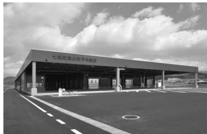
集出荷予冷施設
