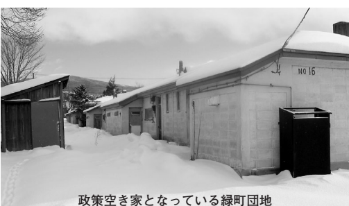
政策空き家となっている緑町団地
