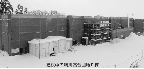
建設中の鳴川高台団地E棟
